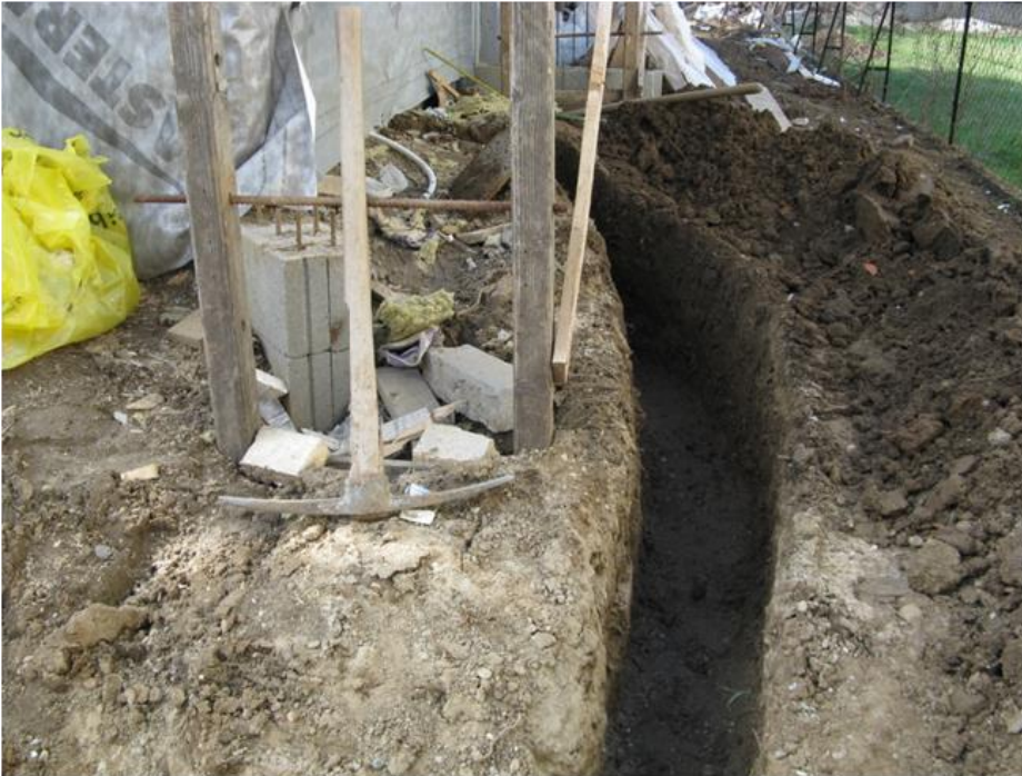
Az építési állvány lába omlásveszélyes talajra, szakadólapra támaszkodik
