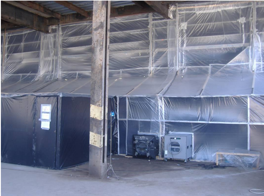
Azbesztmentesítési munkaterület elszigetelése
