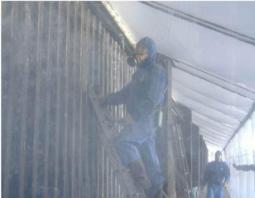
Azbesztmentesítést végző munkavállalók teljes védőöltözetben
