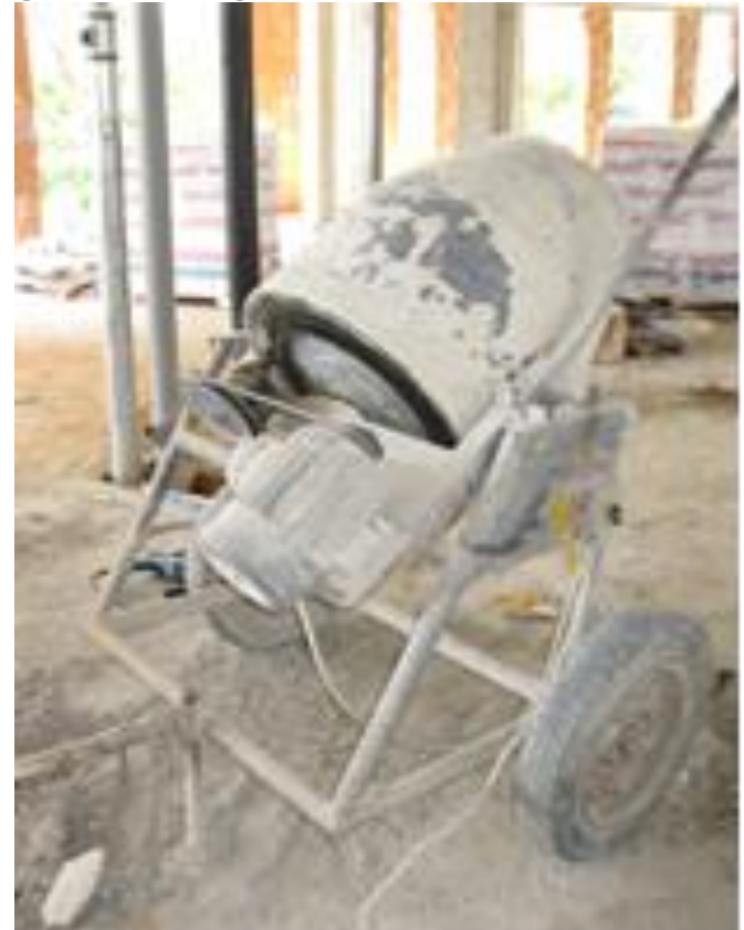
A betonkeverő gép ékszíjhajtásának védő-burkolata hiányzott
