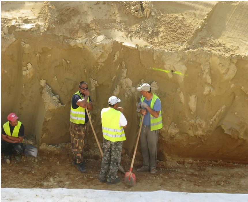
Megtámasztás nélküli függőleges földfal Védősisak használatának mellőzésével „dolgozó” munkavállalók
