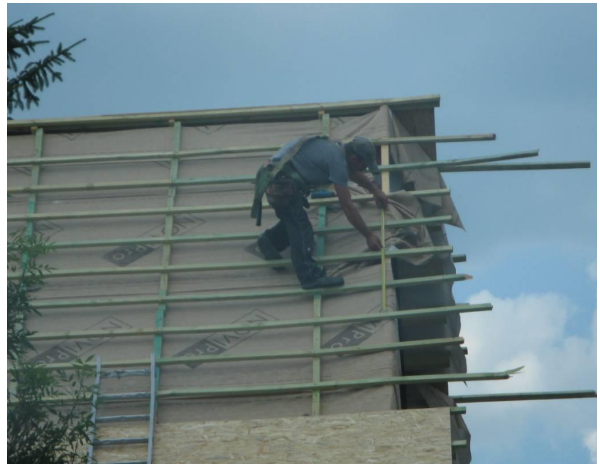
Leesés elleni védelem használata nélkül történő munkavégzés a családi ház tető-szerkezetén és védősisak hiánya
