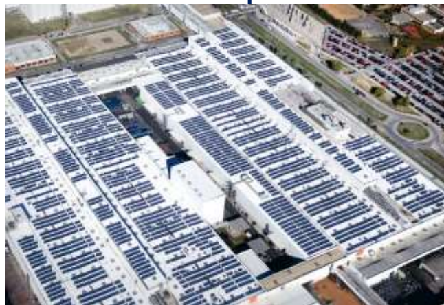
12 MW napelemes rendszer SEAT autógyár, Martorell, Spanyolország
